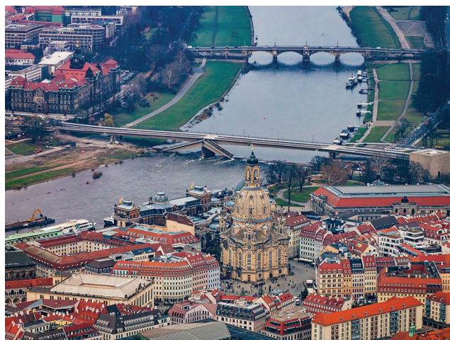
Abb. 1: Die Carolabrücke der Stadt Dresden stürzte am 11.09.2024 schlagartig ein. Als Ursache wird vor allem eine wasserstoff-induzierte Spannungskorrosion vermutet. Dafür wird der in der ehemaligen DDR verwendete Hennigsdorfer Spannstahl verantwortlich gemacht. Die Kosten des Wiederaufbaus werden mit ca. 180 Mill. € veranschlagt.
