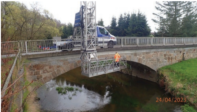
Abb. 4: Bei der Hauptprüfung nach DIN 1076 sind alle Bauteile des Ingenieurbauwerks handnah zu prüfen. Hierbei kommen Besichtigungsgeräte zum Einsatz, die je nach Bauwerk so ausgewählt werden, dass der Prüfer per Hammer, Risslupe und anderem Werkzeug alle Flächen fachgerecht untersuchen kann. Verkehrliche Einschränkungen sind dabei oft unvermeidbar.
