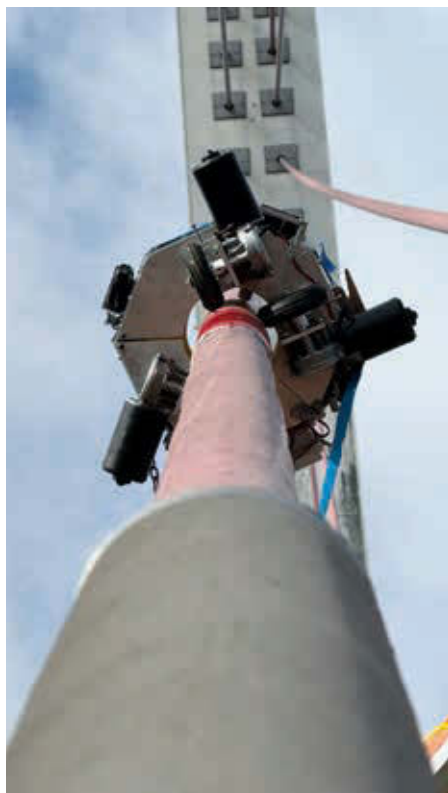
Seilbefahrungsgerät im Einsatz an der Rheinbrücke Neuwied © Landesbetrieb Rheinland-Pfalz
