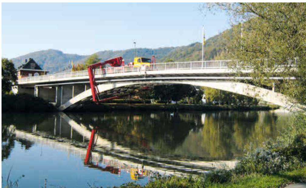
Prüfung der Lahnbrücke in Nievern © Landesbetrieb Rheinland-Pfalz
