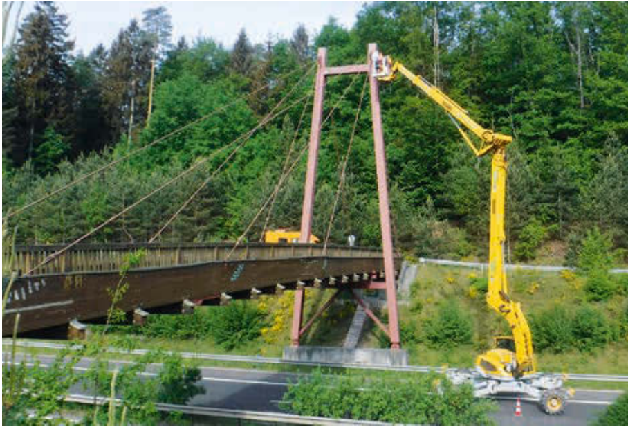
Prüfung der Brücke über die B10 am Ständenhof © Landesbetrieb Rheinland-Pfalz
